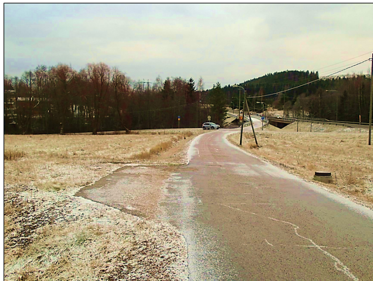
Okeroinen-Renkomäki tie. Okeroisten eritasoliittymän pohjoispuoli. Kevyenliikenteen väylä noudattaa vanhaa tielinjaa. Etelään.
