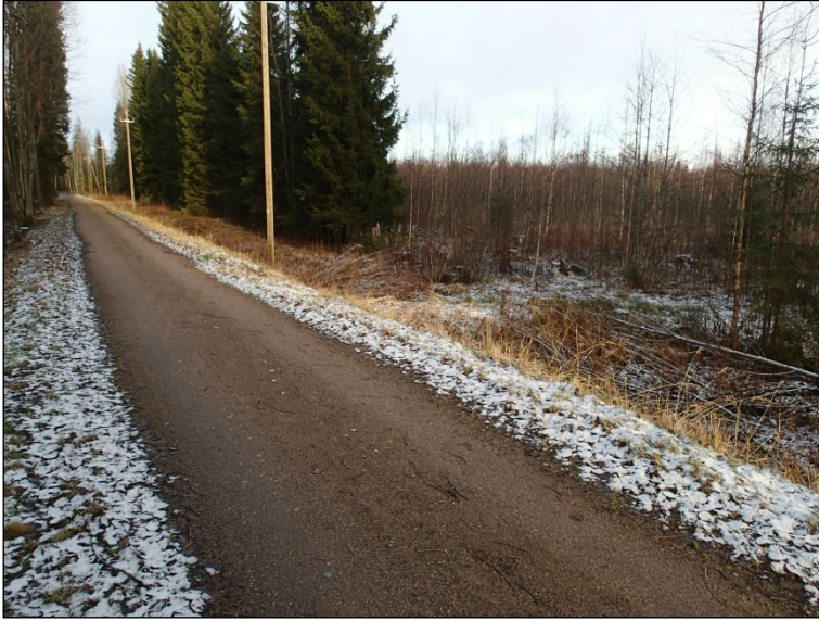
Kujala etl:n länsipuoli. Suunniteltu tielinja ylittää vanhan ratapohjan tällä paikkaa. Koilliseen.
